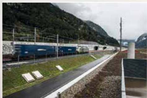
Im Dezember 2016 beginnt der fahrplanmässige Betrieb im Gotthard-Basistunnel.
